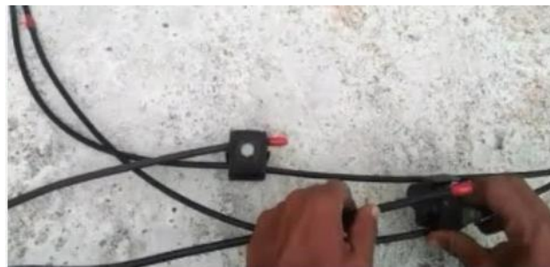
Gambar 2. Penyambungan Conector Langsung
